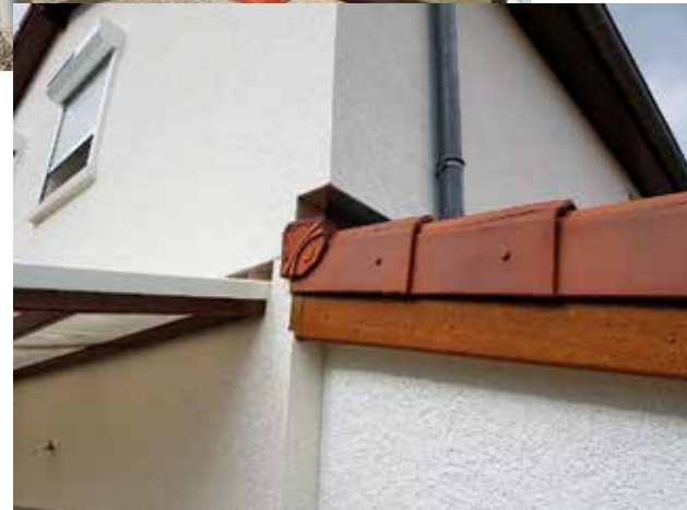
Exemples d'un double vitrage et d'une isolation des murs par l'extérieur
