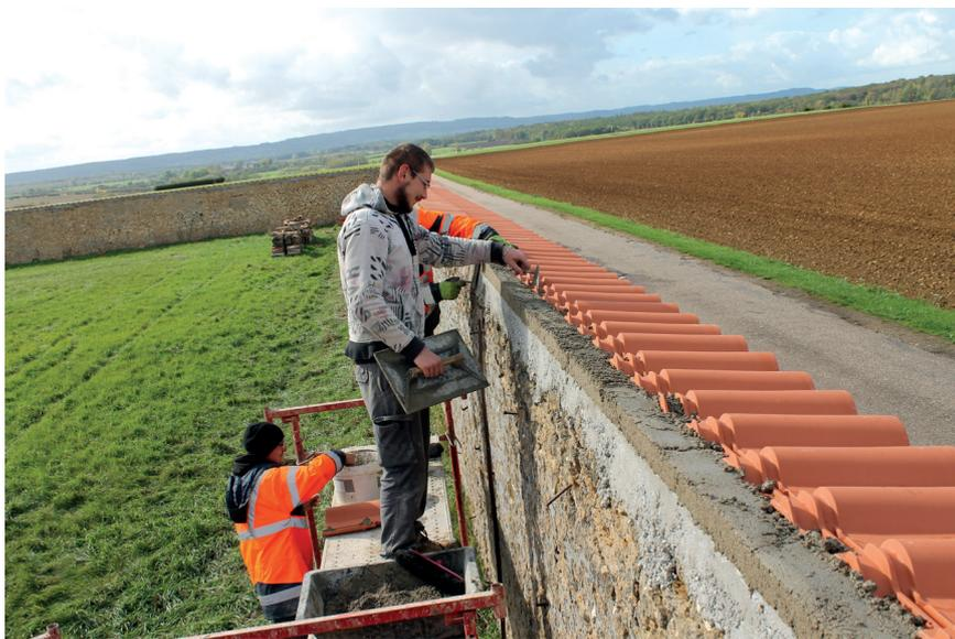
Réfection d'un mur d'enceinte sur la commune de Royaumeix par les agents en insertion : travaux d'étanchéité et pose de quelque 1200 tuiles.
