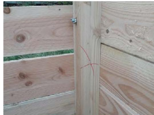
Positionner la face arrière et une face latérale. Vérifier que les trous correspondent à l'aide des repères à placer l'un en face de l'autre.
