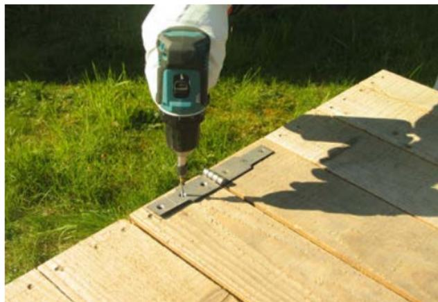
Positionner les deux parties du couvercle l'une en face de l'autre, les charnières préposées sur le dessus. Fixer la charnière sur les emplacements des vis pré-perçés.
