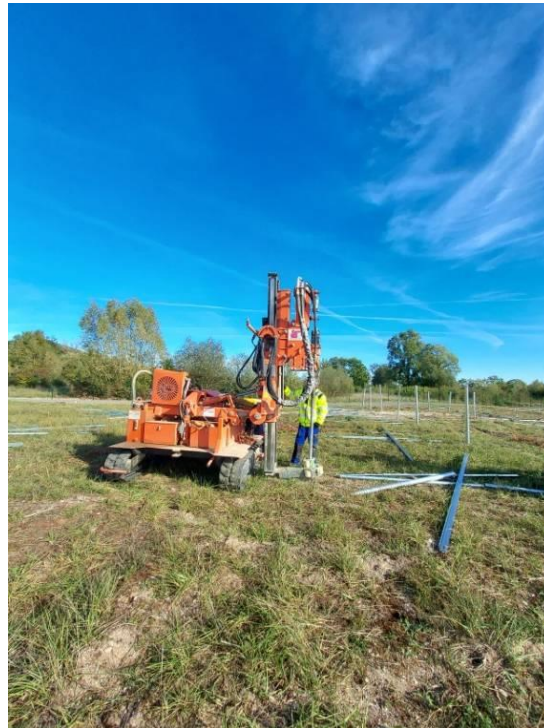
Pré-forage pour implantation des pieux vissés
