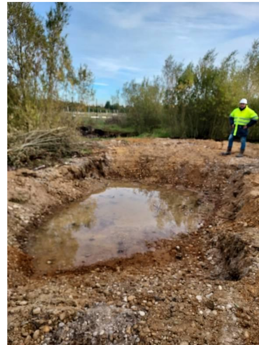
Creusement et éclaircissement de la mare
