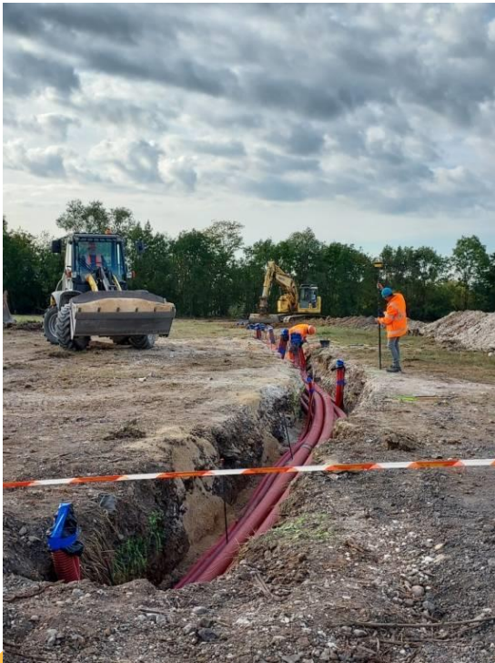
Tranchées raccordement électrique interne
