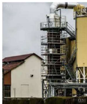
La CCPCST a pour projet, avec six autres intercommunalités, d'acheter l'incinérateur de Tronville-en-Barrois. Photo ER
