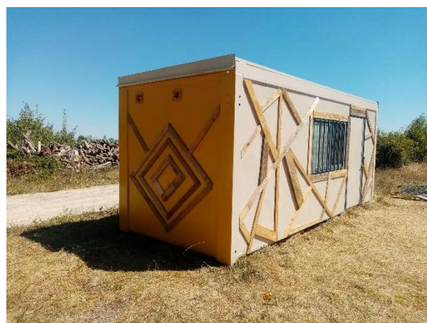
Le bungalow après réhabilitation
