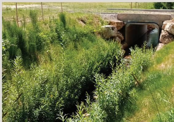
En réduisant la longueur du tronçon recouvert et en augmentant la section d'écoulement on facilite le transport des sédiments et la libre circulation des espèces.
