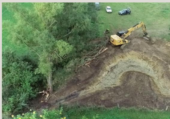
La mise en place d'un dispositif épuratoire en sortie de drainage permet de limiter les rejets de polluants en milieu naturel.
