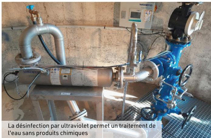
La désinfection par ultraviolet permet un traitement de l'eau sans produits chimiques
