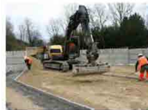
La pelle mécanique et les ouvriers procèdent au remblai calcaire avant la pose de l'enrobé.
