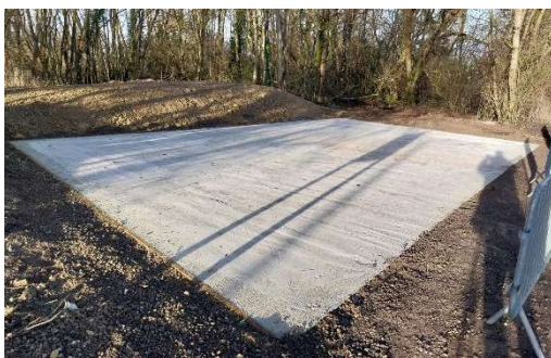
Travaux sur la zone de dépose de Villey-le-Sec
